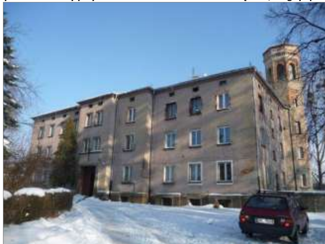
Zdjęcie 13: Budynek mieszkalny przy ul. Górnej 1 w Obornikach Śląskich.
