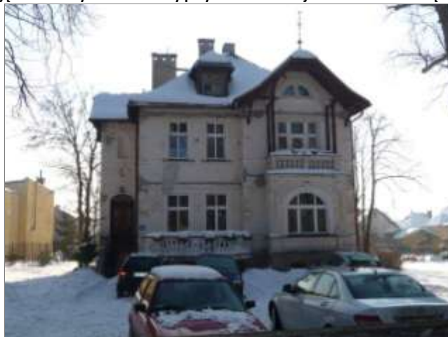
Zdjęcie 16: Budynek mieszkalny przy ul. Skłodowskiej-Curie 20 w Obornikach Śląskich.
